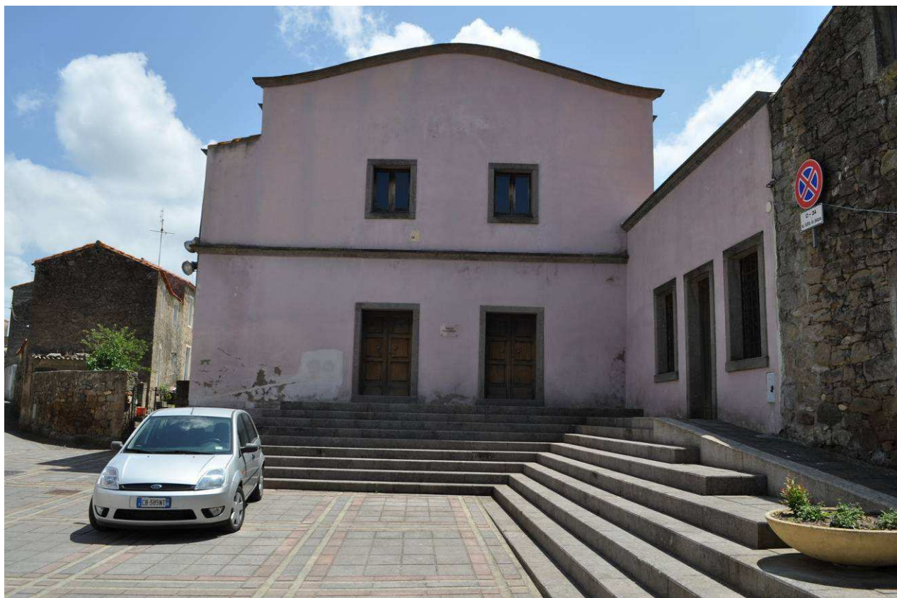
Figura 12 - Recupero primario di edifici storici: l'ex Monte granatico ora Biblioteca Comunale
